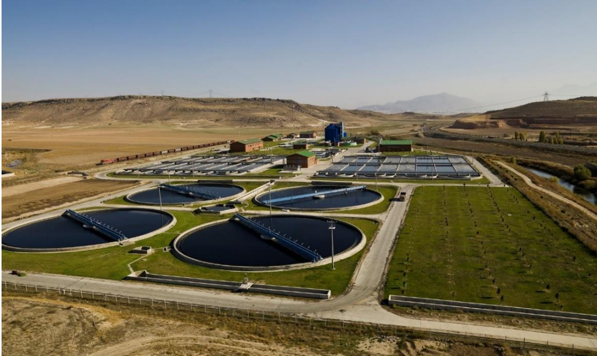
Kayseri İleri Biyolojik Atıksu Arıtma Tesisi
